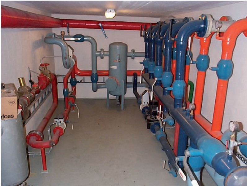
Stjórnstöð snjóbræðslu í Hafnarstræti 19 þjónar snjóbræðslu í Bankastræti, Austurstræti, Pósthússtræti og á Lækjartorgi.
