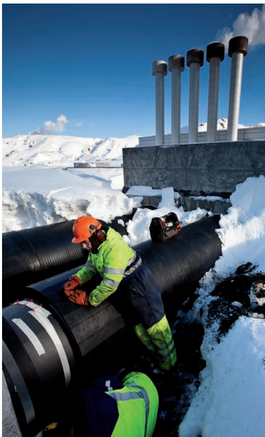
Unnið við lagningu Hellisheiðaræðar við gufulokahús I
